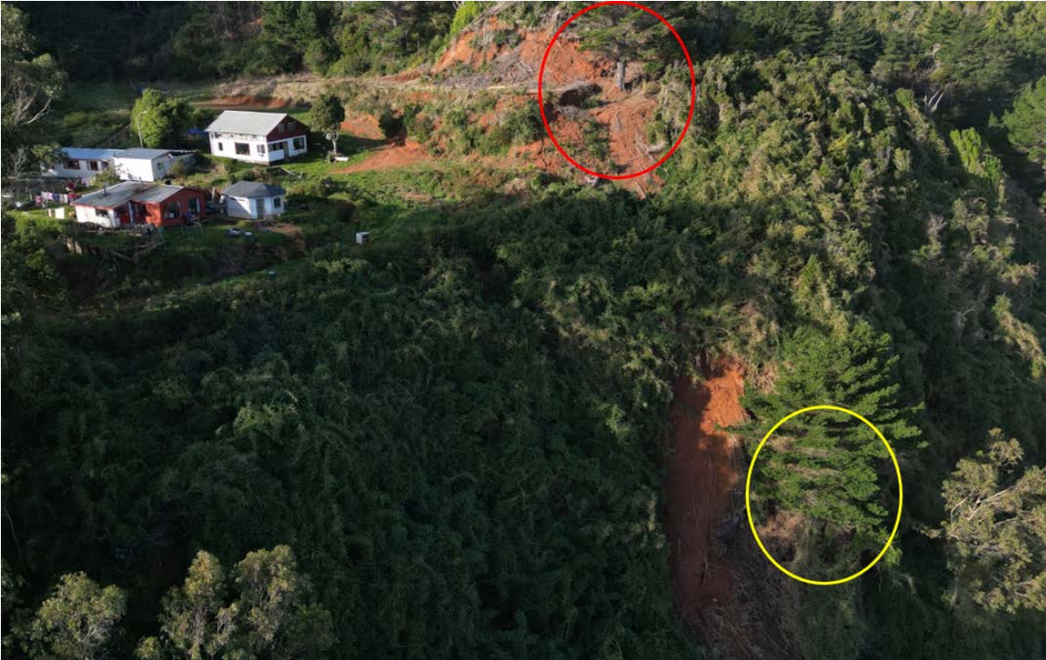
Figura 4. Vista en picado del deslizamiento desde el suroeste. El círculo rojo en el sector del coronamiento de la remoción en masa señala ubicación del árbol de pino que presenta aproximadamente 2 m de asentamiento. El círculo amarillo indica ubicación de árbol de pino que se ubica en mitad de la ladera, inmediatamente sobre el sector de la gruta. Ambos árboles representan una amenaza latente en caso de sufrir colapso de sus raíces y volcamiento.
