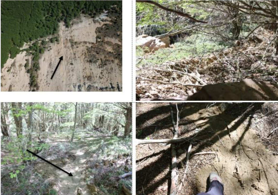
FIG. 10. Se muestra un remante de flujo de lodo por deshielo en el mismo sector de la ladera y zona de alcance de caída de rocas.
