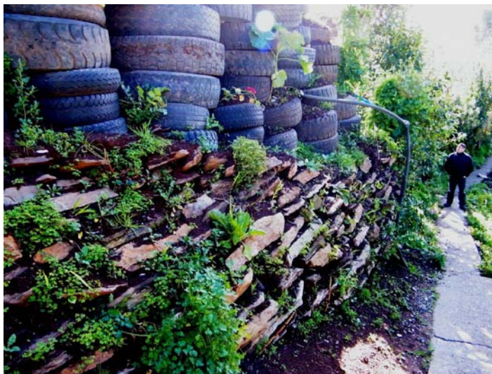
Fig. 1 Pared casi vertical de la “terrazza” de la vivienda del Sr. Pacheco, Pasaje Ernesto Riquelme s/n, adosada a la ladera occidental de la quebrada de fuerte pendiente. Se observa el material rocoso (esquistos) empleados en la base y neumáticos en la parte alta para contener las arcillas de relleno. Además se advierte la vía peatonal o vereda de hormigón en su base (derecha abajo), única vía de acceso a viviendas localizadas aguas abajo.
